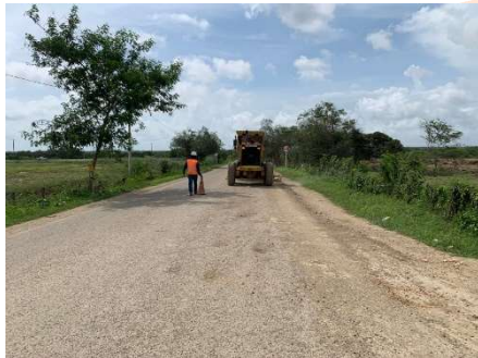
SERENA DEL MAR Pie de foto: Limpieza, humectación y señalización de la vía de Tierra Baja.
