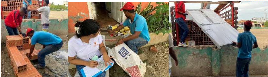
Pie de foto: Donación de materiales para construcción de baño a familia en la comunidad de Manzanillo del Mar y gestión de mano de obra.
